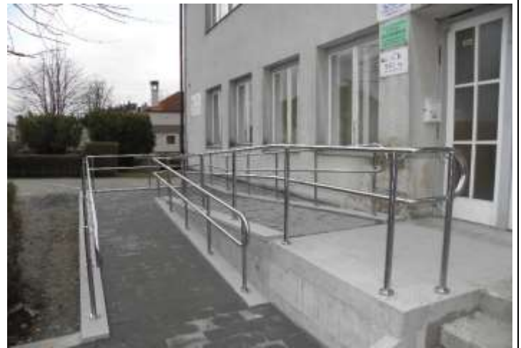
Rekonstrukcija javne zgrade : Ulica Vladimira Nazora
