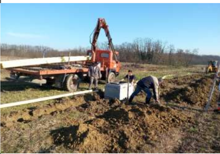
Izgradnja infrastrukture u Poduzetničkoj zoni Kapelica
