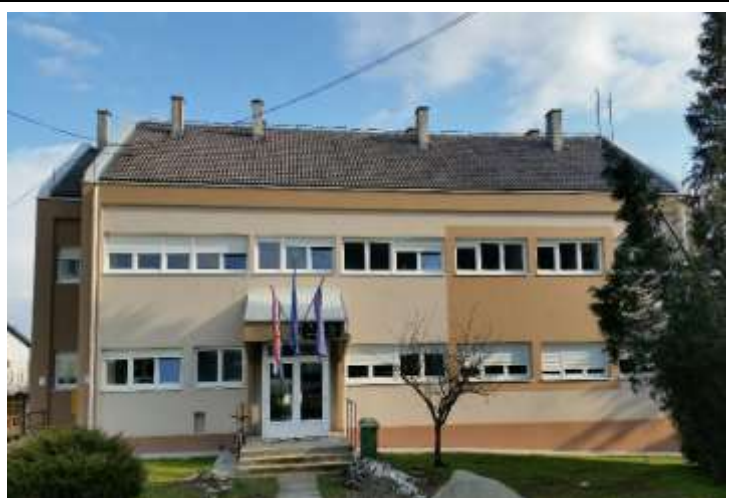
Modernizacija ulaza zgrade Gradske uprave
