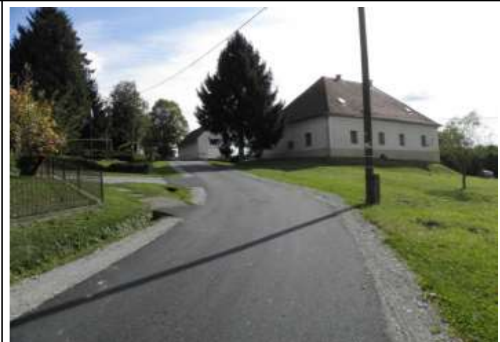
Asfaltiranja u Kaniškoj lvi
