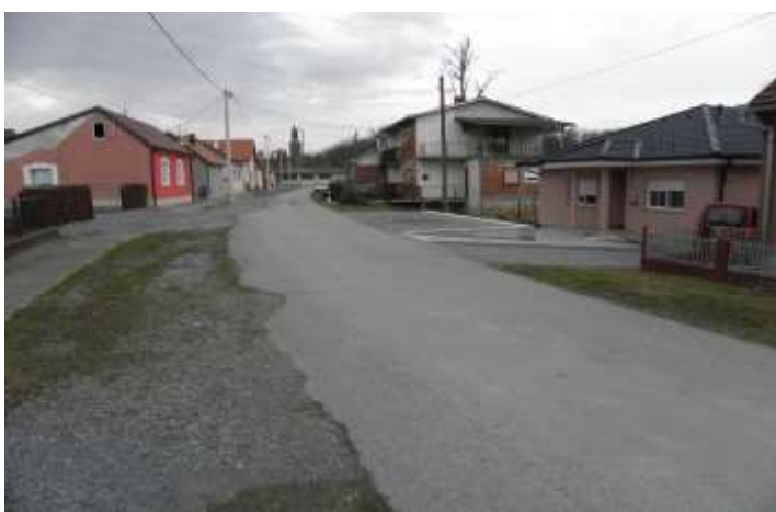
Rekonstrukcija Radničke ulice u Garešnici
